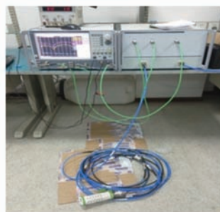
图11 被测电缆故障定位测试
